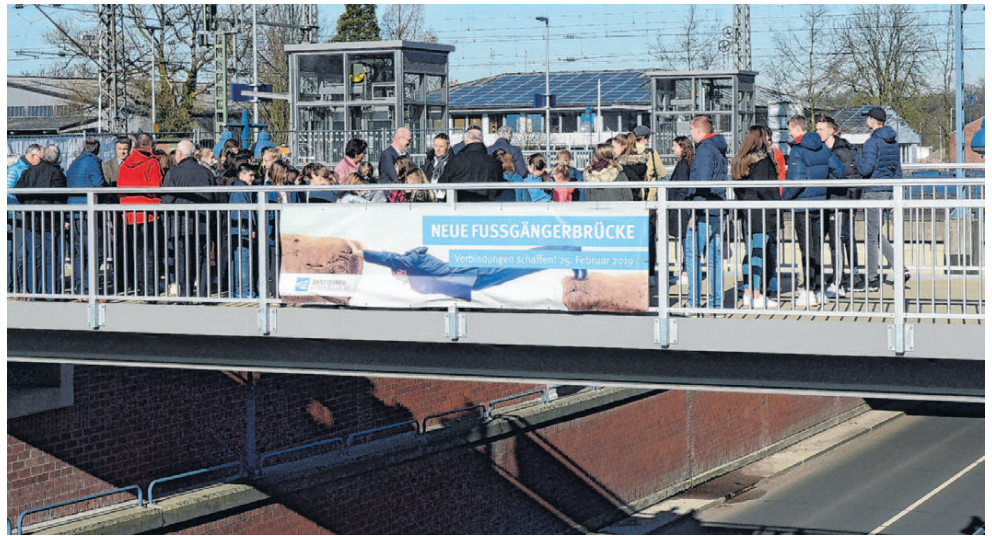
Offiziell freigegeben ist die neue Fußgängerbrücke über die B 403 in Bad Bentheim. Sie verbindet Bahnhofsvorplatz mit „Höger-Bau“ und Burg Gymnasium.
